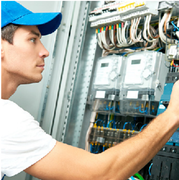
Edificios Existentes. Rehabilitación de Sistemas de Control
